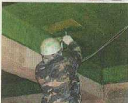
アラミド繊維による補強の様子
